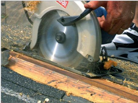
La ranura puede cortarse en un techo nuevo antes o después de la instalación de las tejas o en una remodelación.
