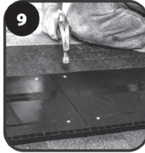
9 Fije el modelo Deck-Air® por los orificios para clavos usando los clavos anillados de 2 1/2" provistos. Deje un espacio de 1/8" entre cada conducto de ventilación para permitir que haya una expansión en climas calurosos.
