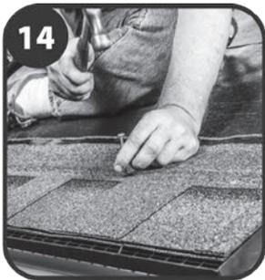
Instale las tejas iniciales y las de la primera hilera encima del solado instalado. No clave en el área de la ranura de ventilación.
