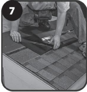
7 Instale el modelo Deck-Air® sobre la ranura usando el método de terminación elegido previamente en el paso 1.
