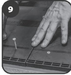
Fije el modelo Deck-Air® por los orificios para clavos usando los clavos anillados de 2 1/2" provistos. Deje un espacio de 1/8" entre cada conducto de ventilación para permitir que haya una expansión en climas calurosos.
