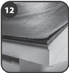
Instale el solado encima del modelo Deck-Air®. **Este se debe colocar debajo de la siguiente capa** para asegurar que el drenaje del techo vaya encima de la parte superior del conducto de ventilación, modelo Deck-Air®.
