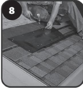
8 Fije el modelo Deck-Air® por los orificios para clavos usando los clavos anillados de 2 1/2" provistos. Deje un espacio de 1/8" entre cada conducto de ventilación para permitir que haya una expansión en climas calurosos.
