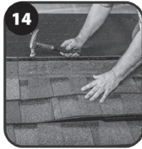
14 Instale las tejas iniciales y las de la primera hilera encima del solado instalado. No clave en el área de la ranura de ventilación.
