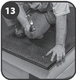
Alinee las tejas iniciales y las de la primera hilera con los topes de las tejas del modelo Deck-Air® para asegurar que las aberturas de ventilación superior no estén tapadas.
