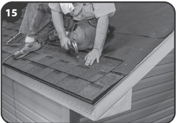
Cuando haya instalado el modelo Deck-Air®, continúe con la instalación normal de las tejas.
