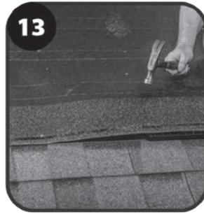
13 Alinee las tejas iniciales y las de la primera hilera con los topes de las tejas del modelo Deck-Air® para asegurar que las aberturas de ventilación superior no estén tapadas.
