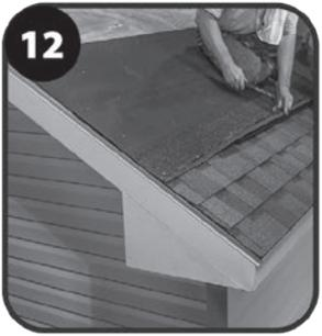
12 Instale el solado encima del modelo Deck-Air®. Este se debe colocar debajo de la siguiente capa para asegurar que el drenaje del techo vaya encima de la parte superior del conducto de ventilación, modelo Deck-Air®.
