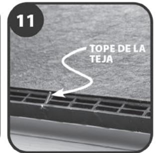
Alinee el borde inferior del solado con los topes de las tejas en el modelo Deck-Air® para asegurar que las aberturas de ventilación superior no estén tapadas.
