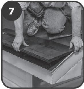
Instale el modelo Deck-Air® sobre la ranura usando el método de terminación elegido previamente en el paso 1.
