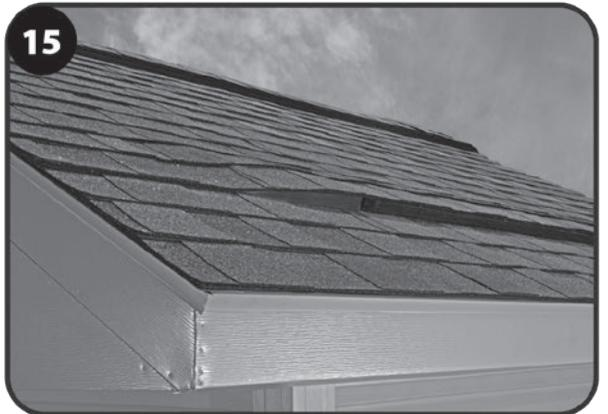
15 Cuando haya instalado el modelo Deck-Air®, continúe con la instalación normal de las tejas.
