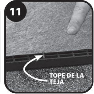
11 Alinee el borde inferior del solado con los topes de las tejas en el modelo Deck-Air® para asegurar que las aberturas de ventilación superior no estén tapadas.
